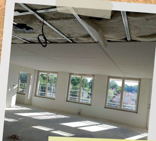
Isolation et pose de plaques de plâtre
