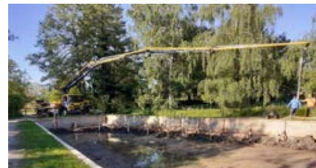
C'est grâce à une grande pompe avec un bras articulé de 36 mètres rallongé de tuyaux amovibles de 21 mètres que les 21 mètres cubes de béton ont été acheminés dans la tranchée, étant donné que l'accès à l'étang n'est pas possible pour les engins lourds.
